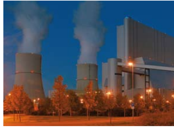
Naturzugkühlturm des Kohlekraftwerks „Schwarze Pumpe“ in Deutschland mit einer Leistung von 2 x 800 MW.
