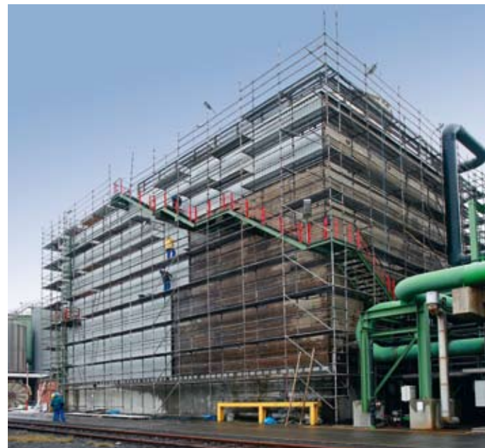
Fassadenerneuerung bei gleichzeitiger Minderung der Schallemissionen aus einer Hand
