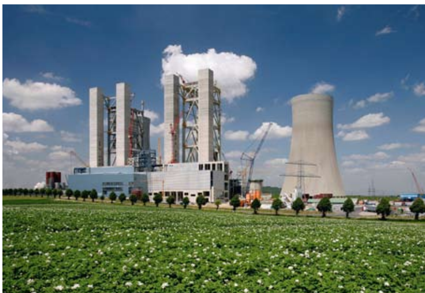
Электростанция Neurath 2 x 1.100 MW e , RWE Power
