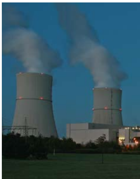
Schwarze Pumpe 2 x 800 MW e , Vattenfall Europe Generation AG & Co KG
