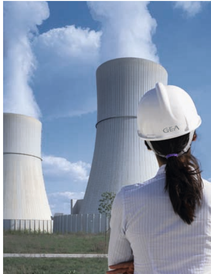
Современная технология охлаждения GEA на крупных электростанциях
